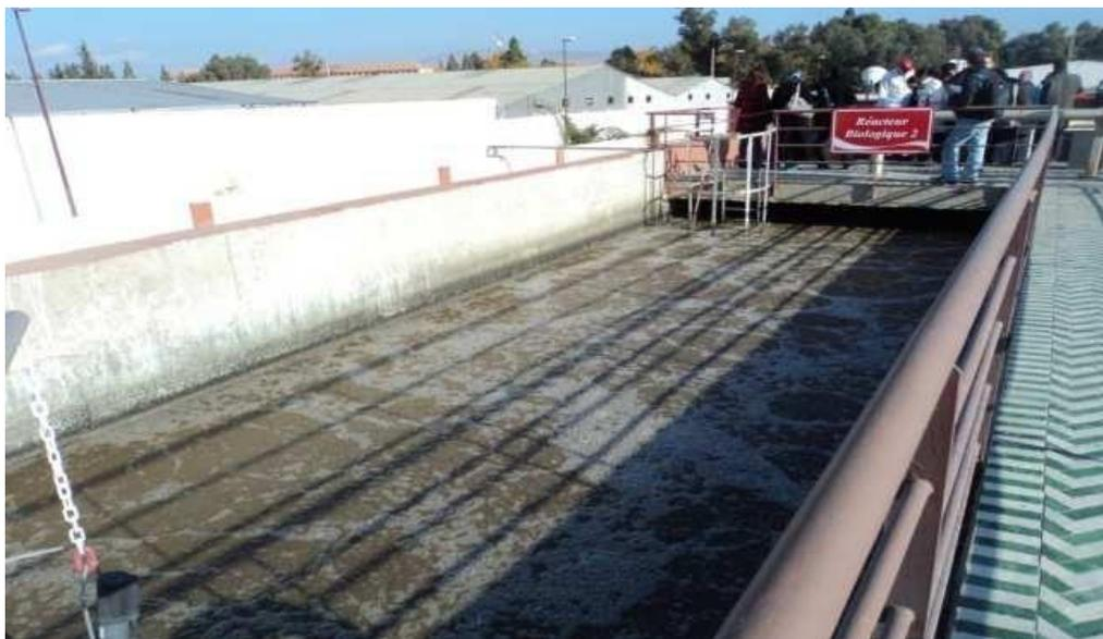
*Figure 7 : réacteur biologique 2 de la STEP de la CBGN*
