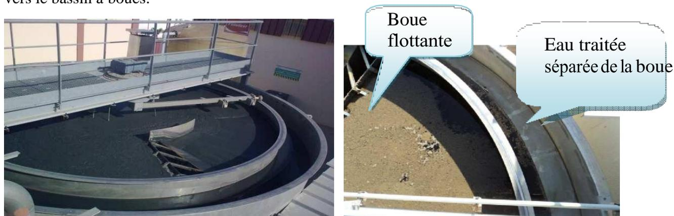
**Figure 8 : à gauche le flottateur à droite la séparation de l'eau traitée des boues**
