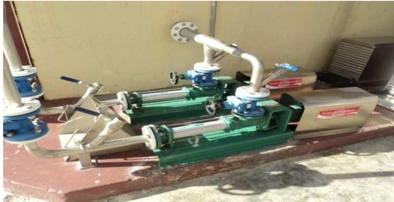
**Figure 10 : pompes d'extraction des boues**
