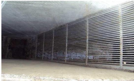
**Figure 3 : Dégrilleur grossier de la STEP de la CBGN**
