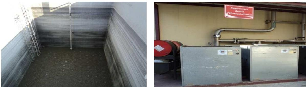
**Figure 5 : bassin d'homogénéisation (à gauche) et (à droite) les suppresseurs du bassin d'homogénéisation**
