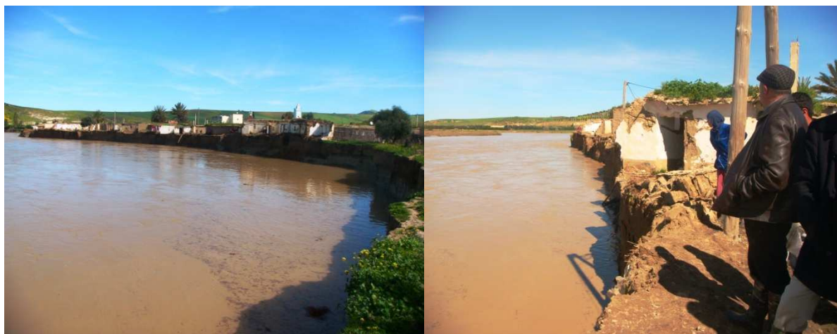
Figure 23 : Images des inondations dans la région de Taounate 2009 /2010
