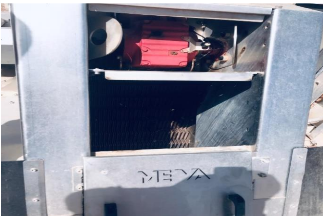
Figure3 : dégrilleurs fin automatiques de type screen
