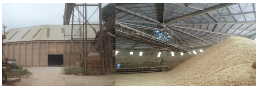
Figure 8: Hall de pré-homogénéisation (Silos de stockage)
