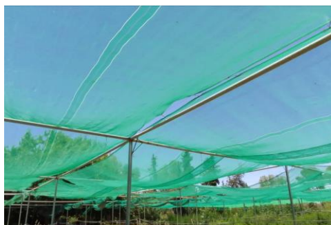
Figure-25 : Image montrant des ombrières (Skalli, 2022)
