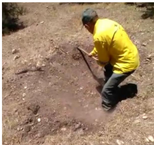
Figure - 39 : Rebouchage de l'élément de banquette
