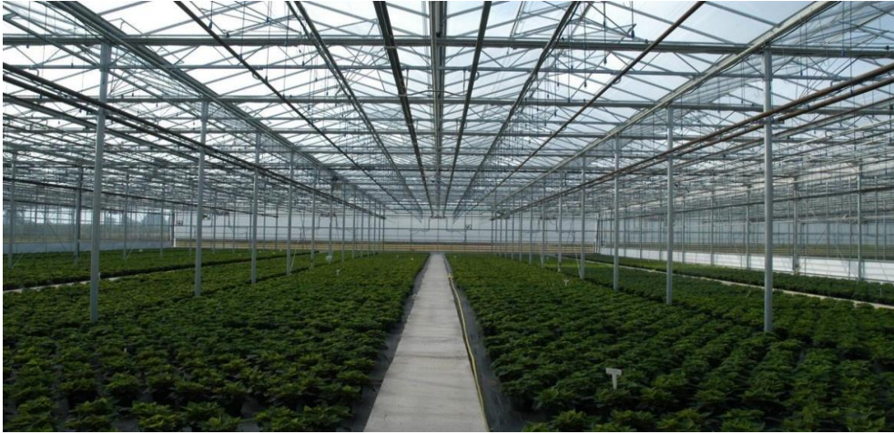
Figure 5 : Exemple de serre agricole
