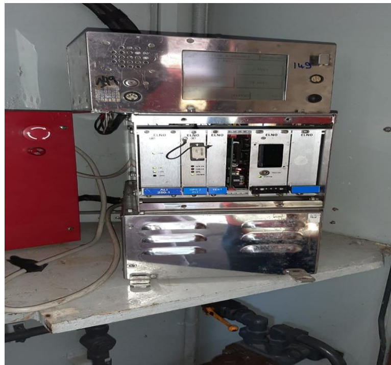
FIGURE 2.1 : EQUIPEMENT DE LA SONORISATION
