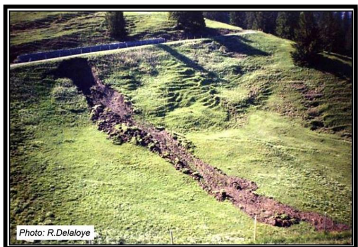
Figure 15: Glissement rotationnel rapide évoluant en coulée boueuse
