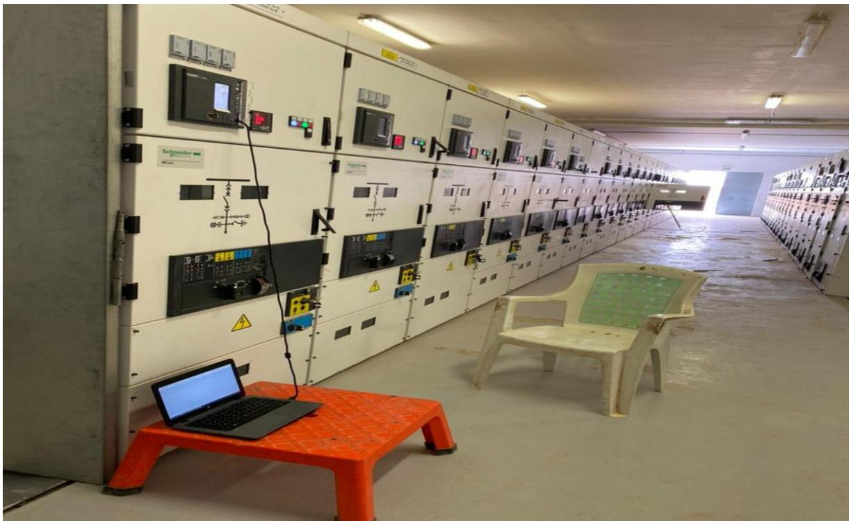
Figure 20 : connexion entre Sepam et PC (Poste Nord)
