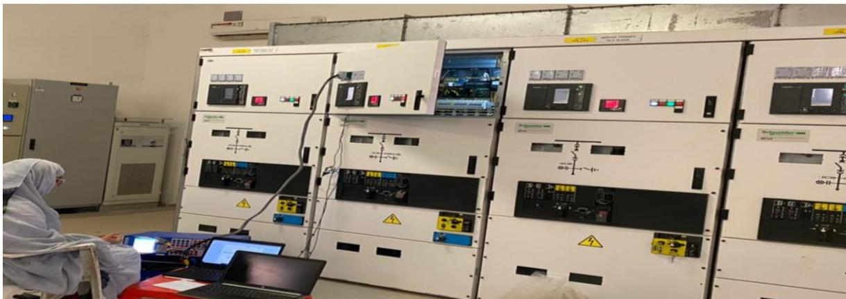
**Figure 36 : Raccordement entre la valise et cellule**
