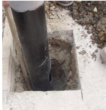
Figure 24 : fixation par enfoncement
