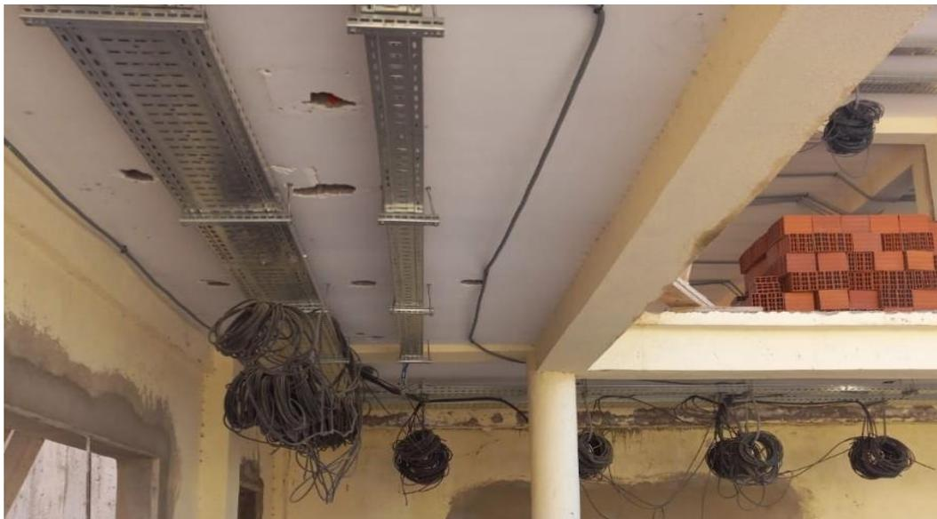
Figure 5 : Modes de pose pour les câbles de réseaux et téléphonie
