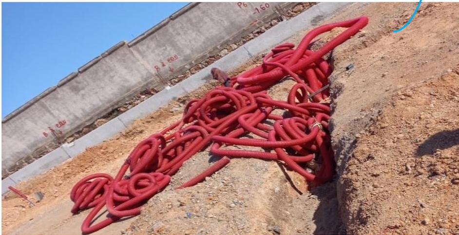
Figure 3 : Canalisation pour les câbles d'éclairage de parc.
