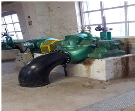
Figure 24 : Pompe centrifuge de type râteau a arbre horizontal
