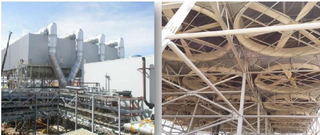
Figure 11 : Aérocondenseurs ACC
