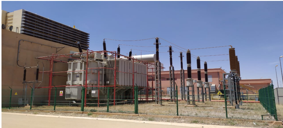
Figure 15 : Schéma de Transformateur abaisseur
