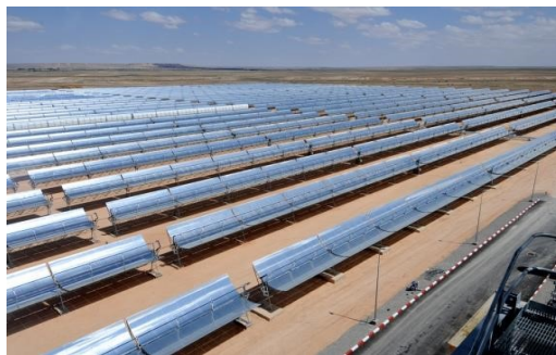
Figure 12 : miroirs cylindro-parabolique
