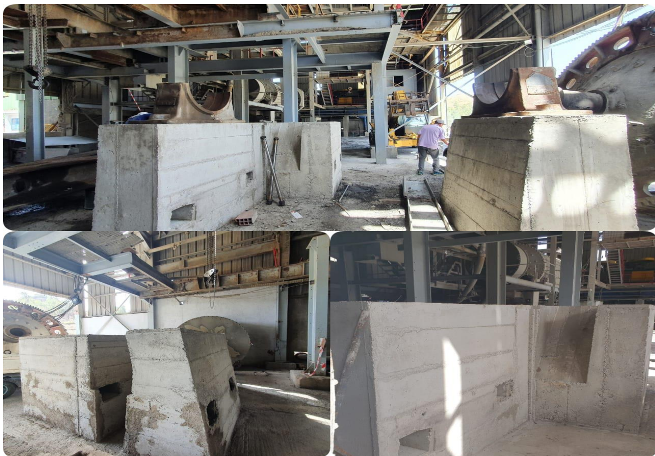
Figure 23 : Construction massif et démarrage de montage mécanique
