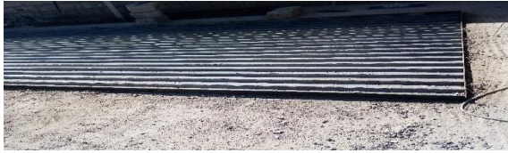
Figure 1.5: les bancs des poutrelles
