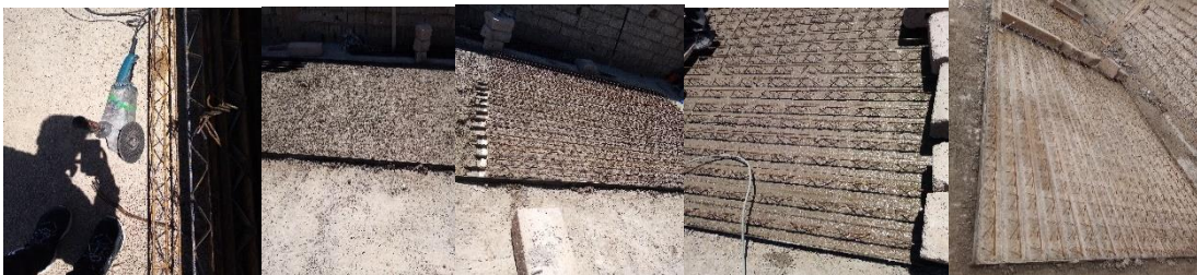
Figure 1.20: les différentes étapes de fabrication des poutrelles
