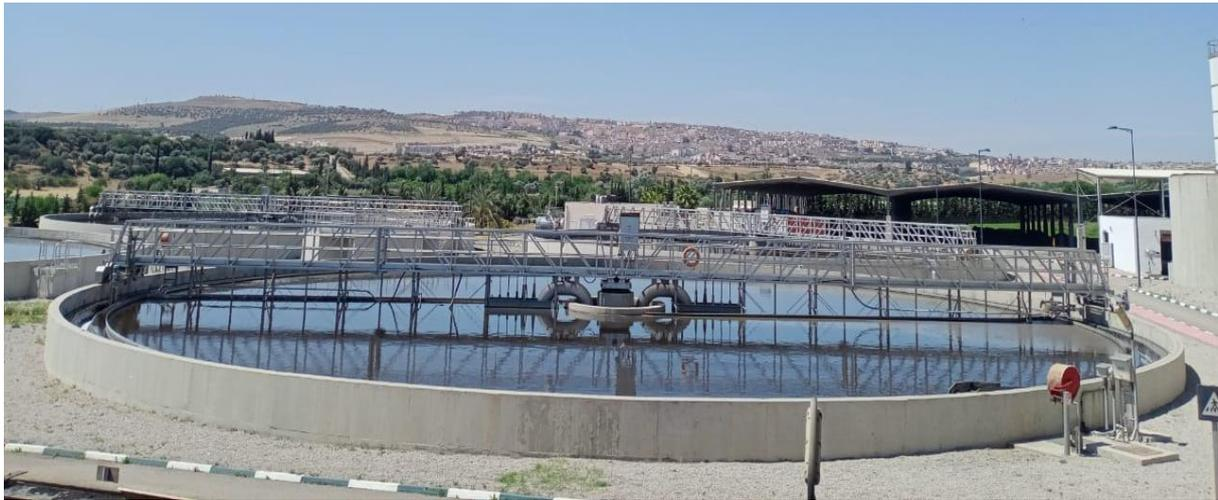
*Figure 7: photo du clarificateur de la STEP de Fès*
