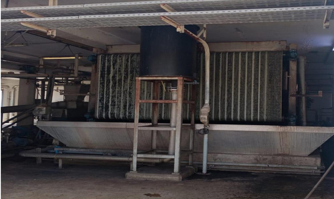
*Figure 13:Filtre à bande de la STEP de Fès*
