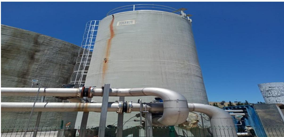
*Figure 10: photo du désulfure de biogaz de la STEP de Fès*
