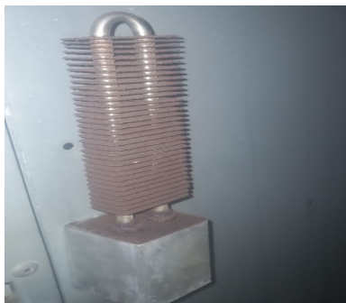
Figure 17 : photo de la résistance chauffante
