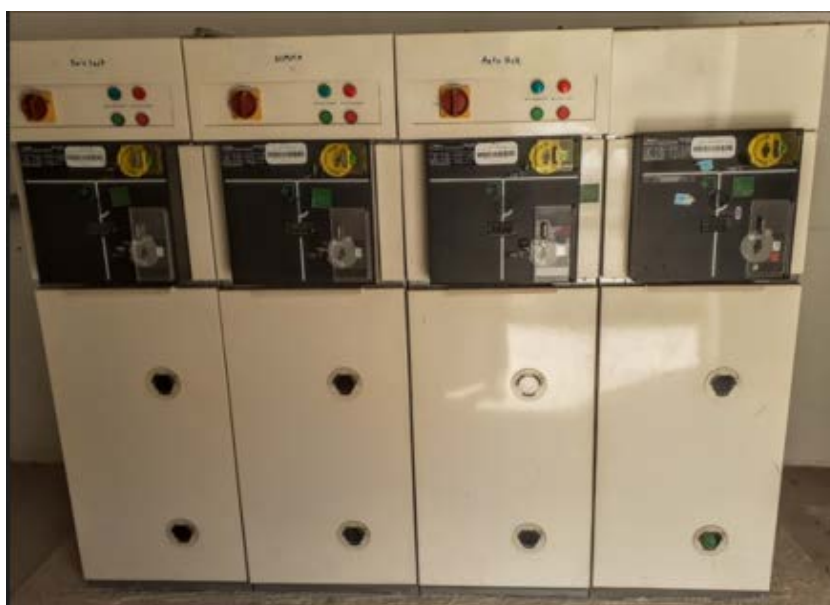
Figure 7 : cellule modulaire HTA
