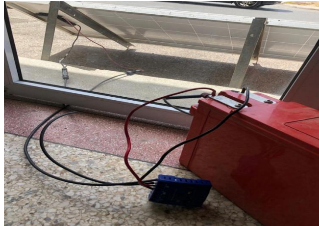
Figure 4 Montage d'un système isolé réalisé à Elec Energie.
