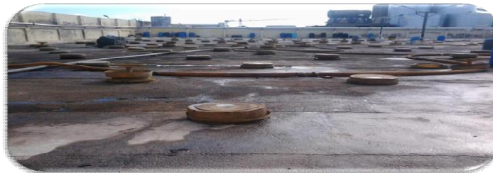
Figure 7: Image des citernes souterraines.
