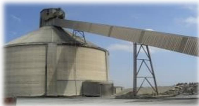
Figure 20 : Silo de clinker.
