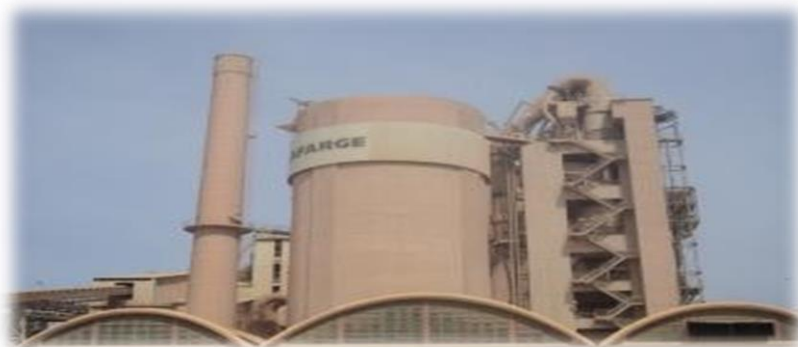
Figure 16 : Poste de préchauffage.
