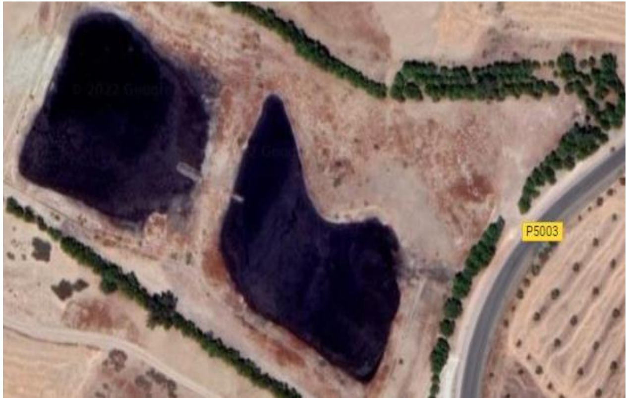
Figure 8. Image satellitaire des deux bassins d'évaporations naturels de la ville de Fès
