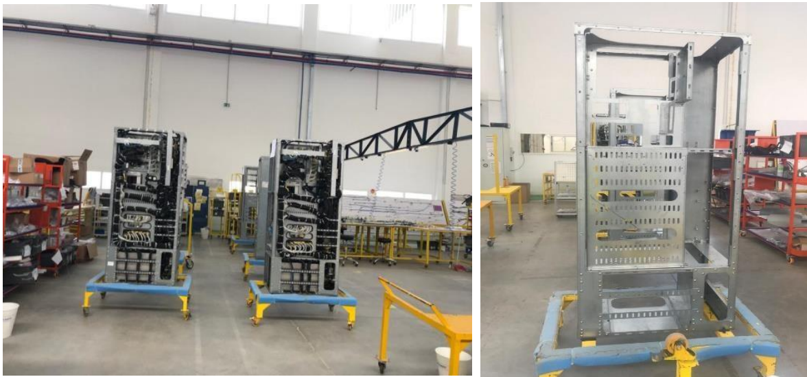
Figure 23: Intégration des armoires
