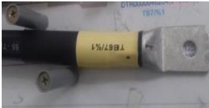
Figure 21: Chauffage des gaines et manchons
