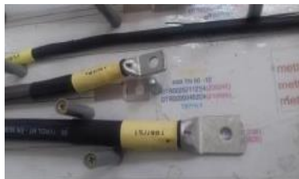
Figure 19: Opération de sertissage des câbles
