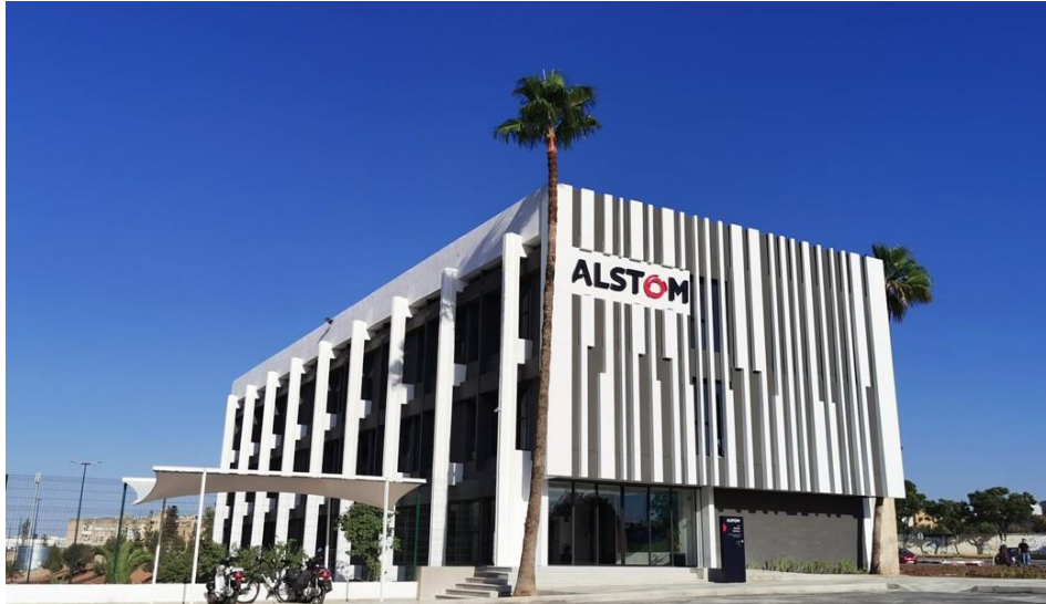
Figure 6: Nouveau site d'Alstom Fès
