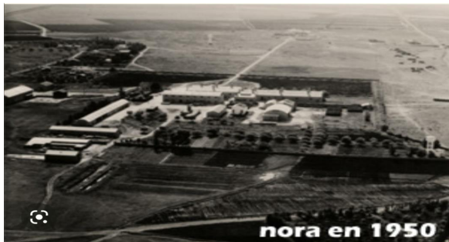
Figure 1 : Vue de l'entreprise
