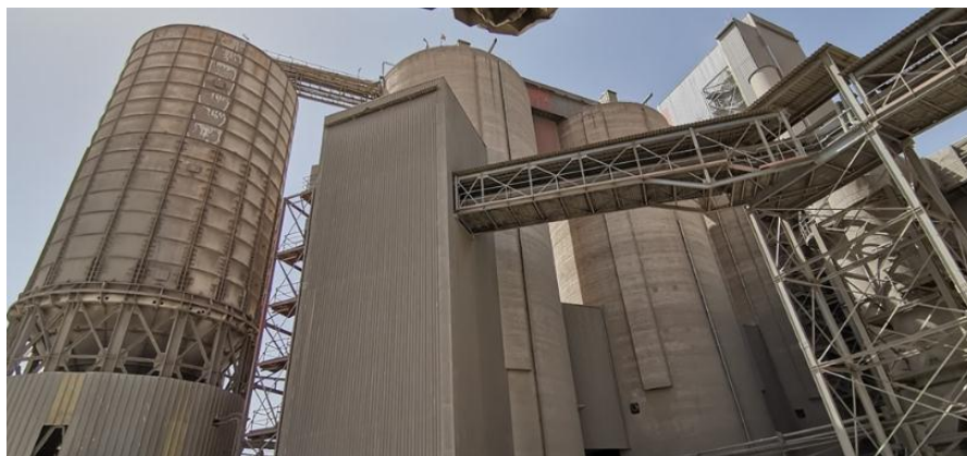
Photo 13: Les silos de stockage de ciment (l'Usine de LafargeHolcim Fès 2022)
