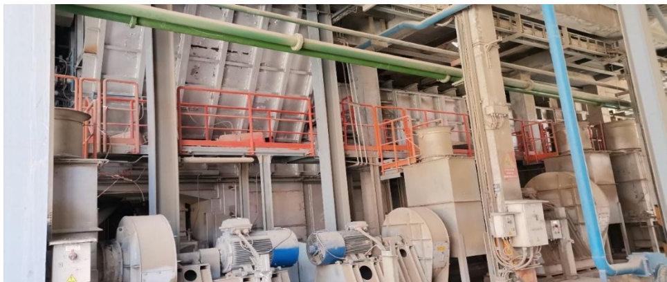
Photo 9 : Refroidisseurs du clinker ( l'usine de LafargeHolcim Fès 2022)
