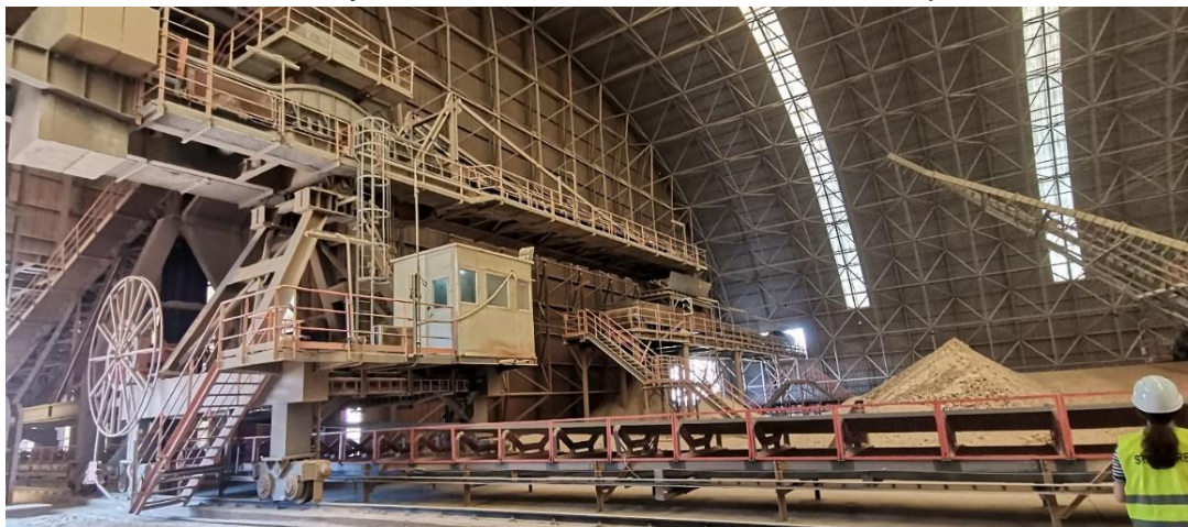
Photo 3 : Hall de pré-homogénéisation (usine de LafargeHolcim Fès 2022)
