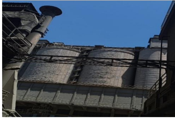
Figure 14 : Les silos du stockage du ciment.
