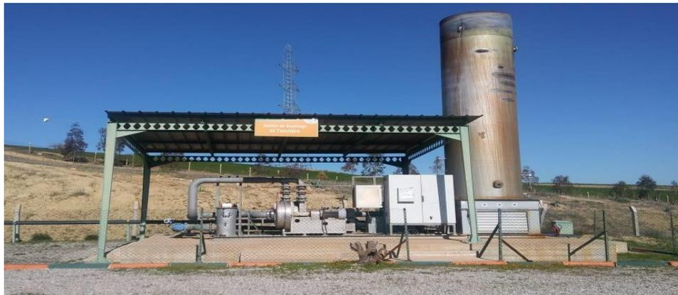
Figure 10: Unité de soutirage du biogaz.
