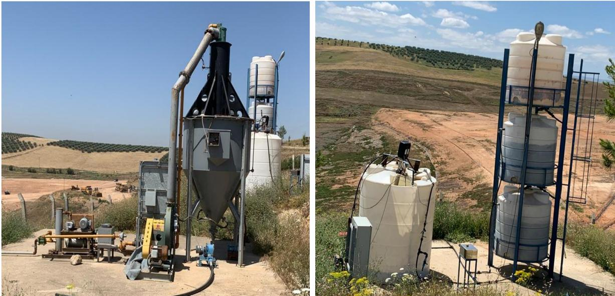
*Figure 13: De gauche à droite, l'évaporateur thermique, filtration par membrane biologique*
