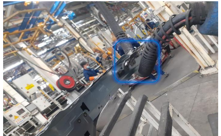
Figure 50 : Les faisceaux dégradés du poste 30
