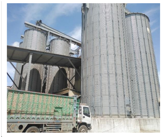
Figure 5 : Photo des silos
