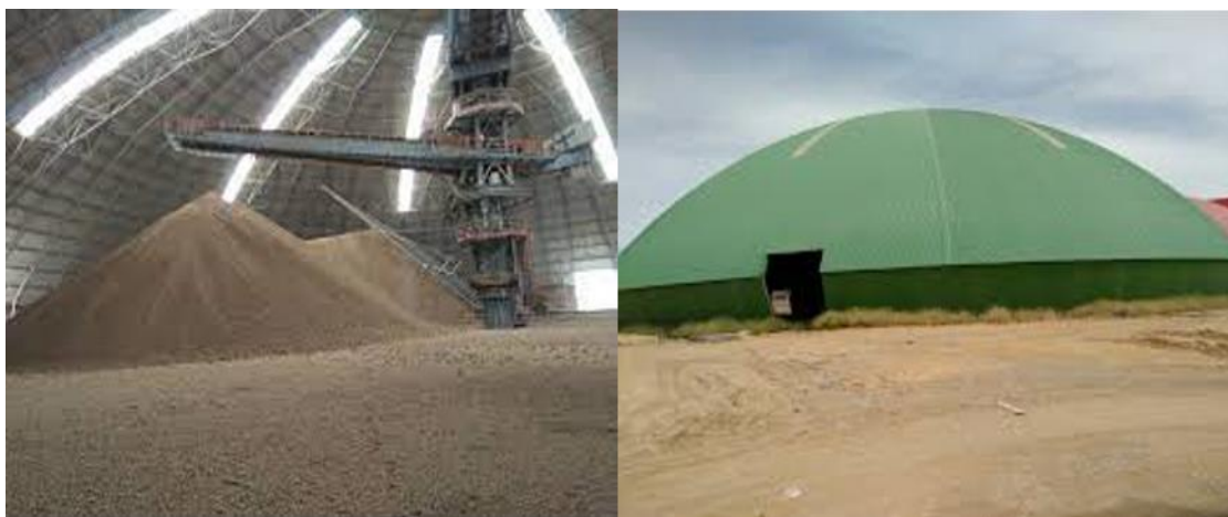
Figure 1.3: Parc de Pré-homogénéisation.
