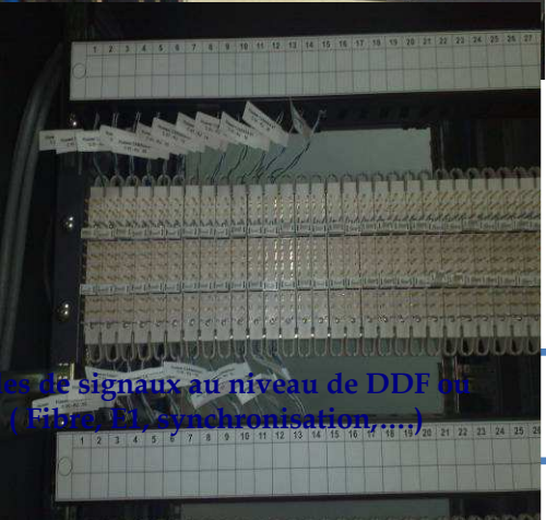
Photo 12: Etiquetage des fibres et d'autres câbles de signal.
