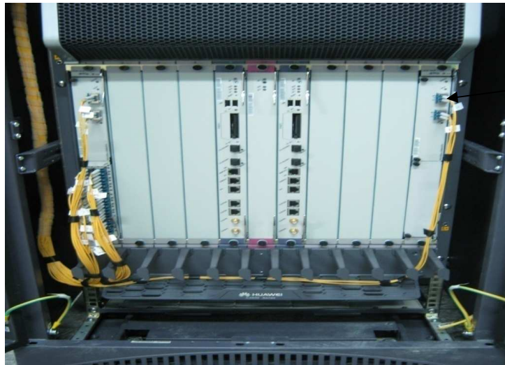
Figure 37: Installation du CX600-X8 pour un site d'agrégation
