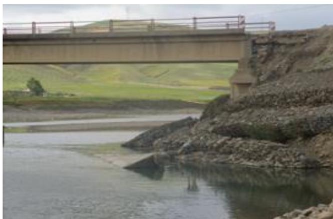
Figure VI-60 : Seuils en gabion défaillant au niveau du pont de Galaz
