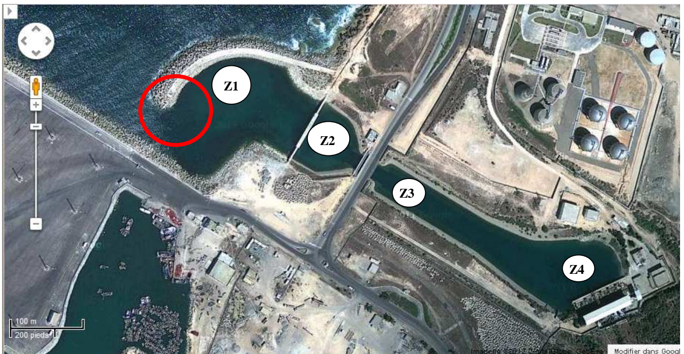
Figure 8 : Photo satellitaire de la Station de pompage de l'eau de Mer
