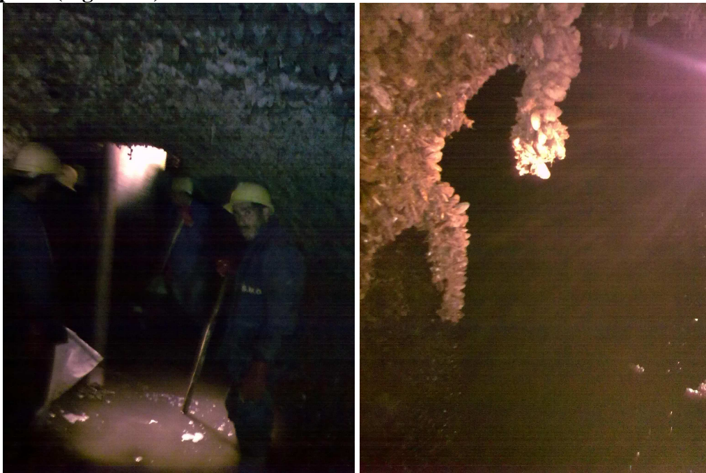
Figure 17 : nettoyage des conduites :
