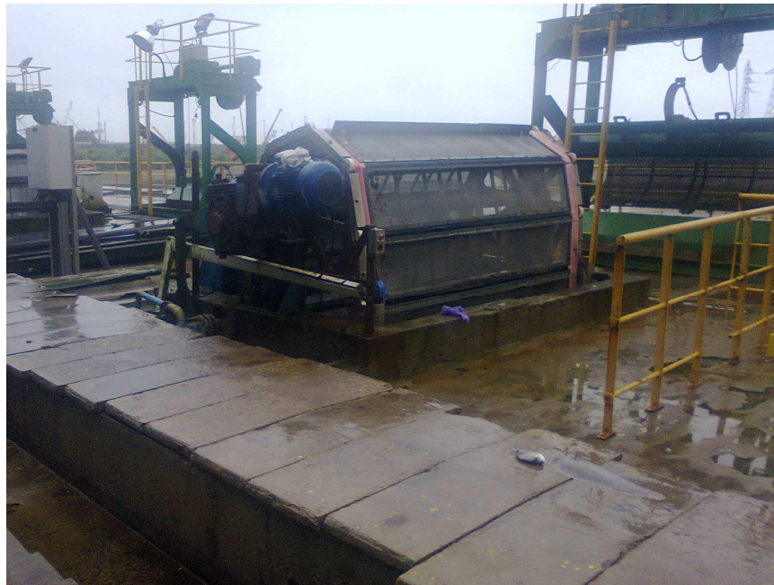
Figure 11 : Filtre de l'eau de mer (diamètre = 2mm)
