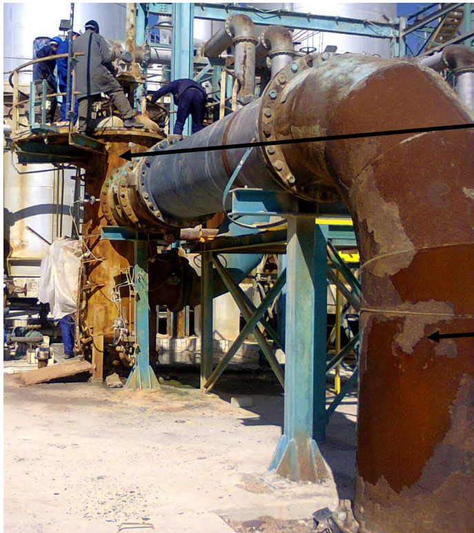
Figure 19 : Conduite et filtre de l'eau de mer de l'atelier de sulfurique :
