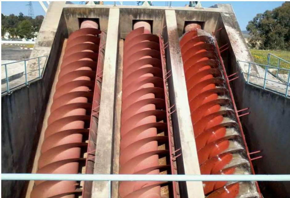
Photo3 : Vis d'Archimède utilisée pour pomper l'eau
