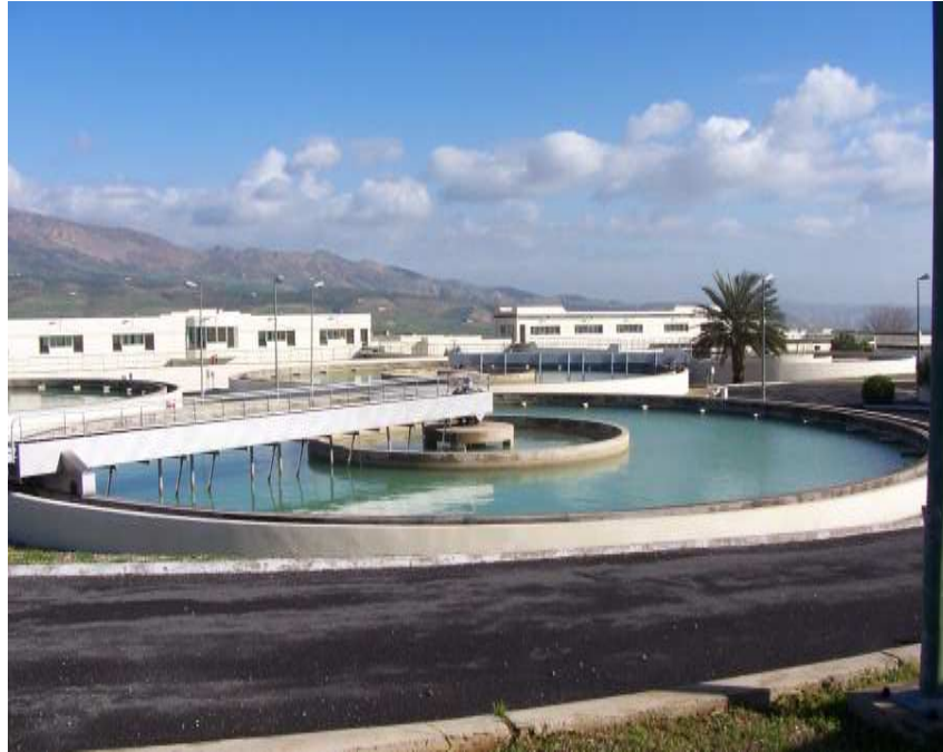
Photo6 : Décanteur cylindrique à racle
