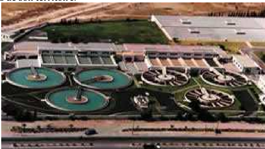
Photo1 : Station de traitement des eaux d'oued Sebou
