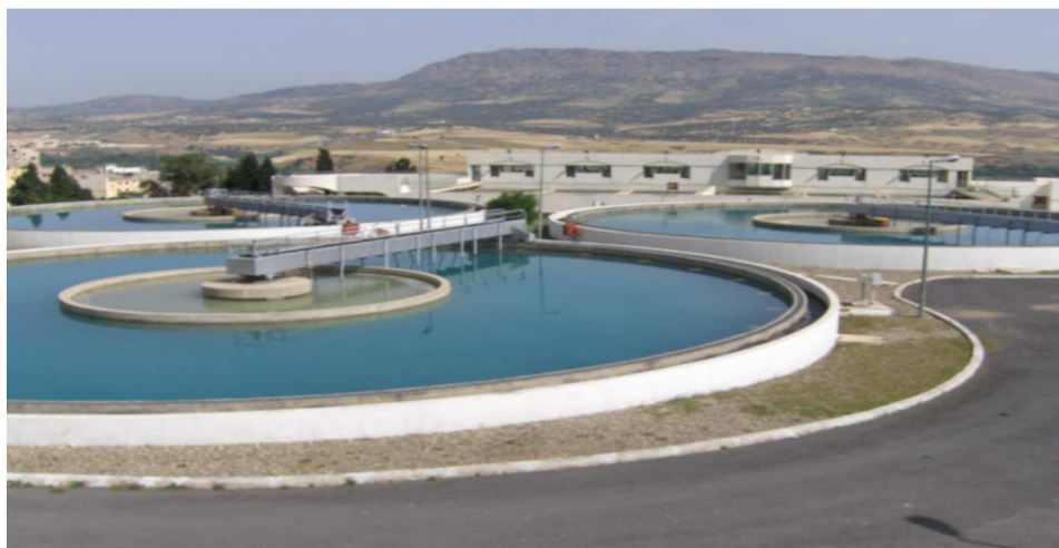
Photo 5 : Décanteurs
