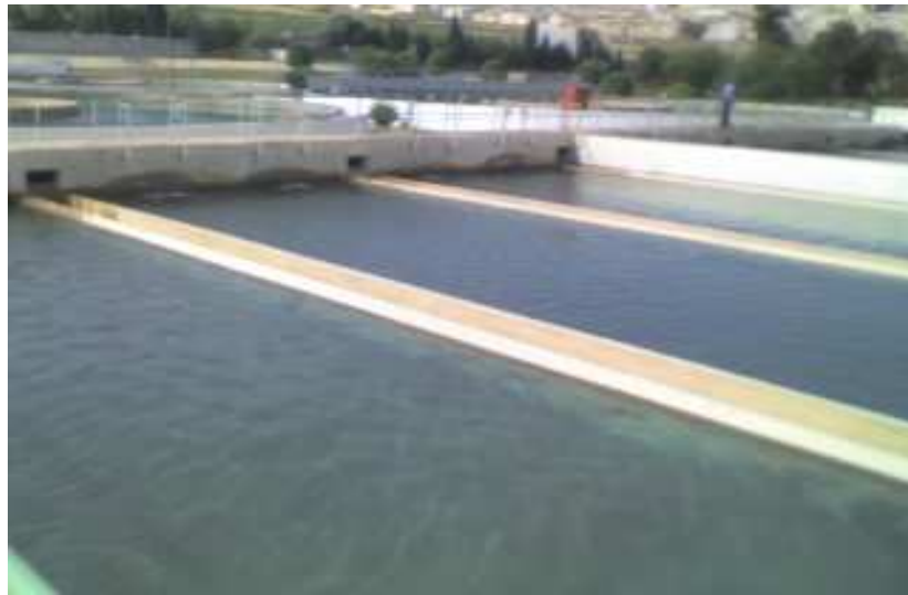
Photo 6 : filtre à sable.
