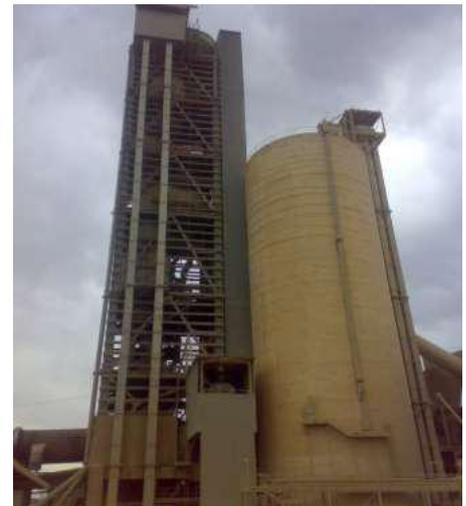
Figure 9 : photo de la tour de préchauffage et du silo d'homogénéisation
