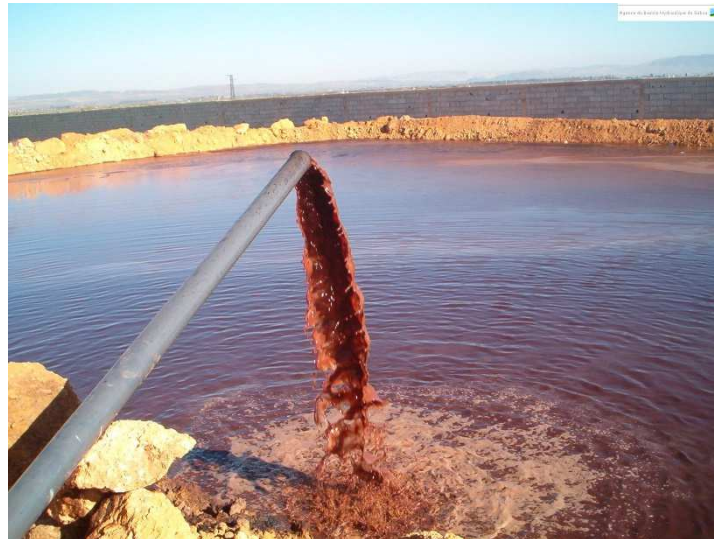
Figure 7: Bassins d'évaporation des margines de la RADEEF (prise le 05/05/2014).
