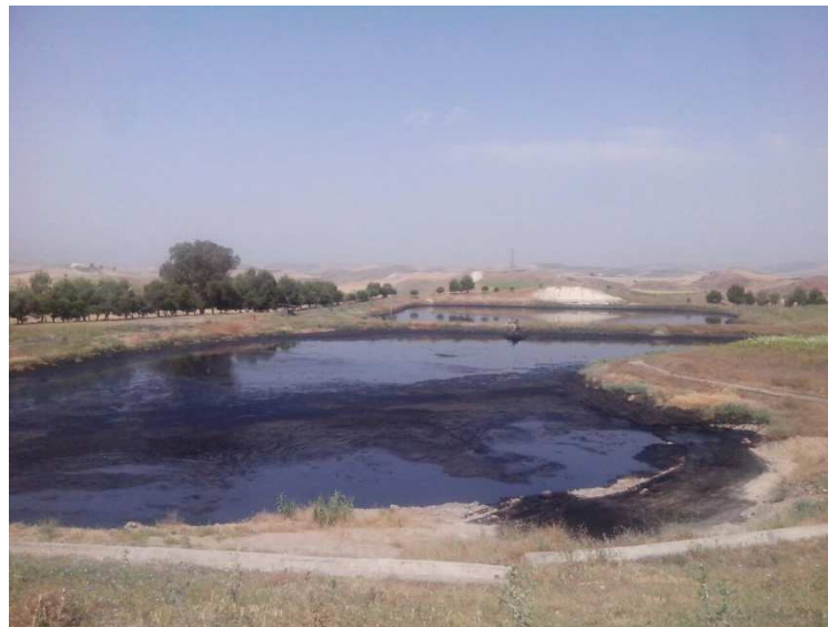
Figure 7: Bassins d'évaporation des margines de la RADEEF (prise le 05/05/2014).
