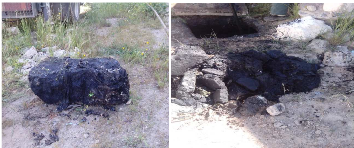
Figure 5: Blocs de pierres extraites d'un regard du réseau dokkarat (24-4-2014).
