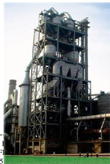
**Figure 7 :** Tour de préchauffage avec un précalcinateur
