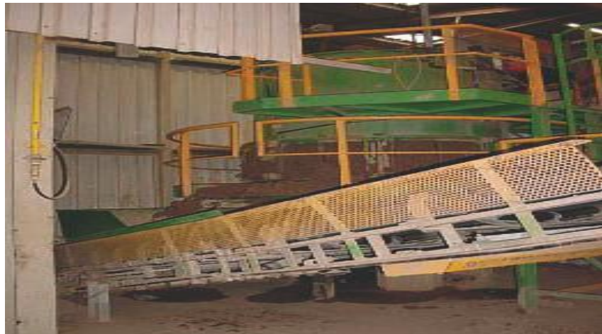
Figure 2.3 : Broyage et malaxage de l'argile.
