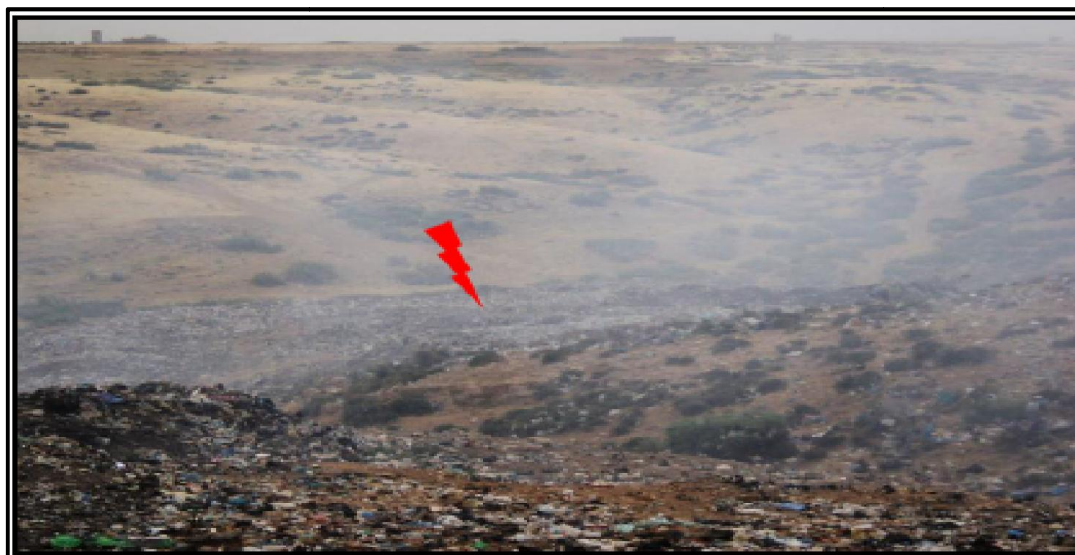
Photo 3: Vue de la décharge actuelle et la châba qui la traverse et qui lie la décharge et l'oued Oum Er-Rbiâ
