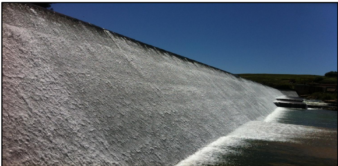
Photo 19: Barrage de Kasba-Tadla
