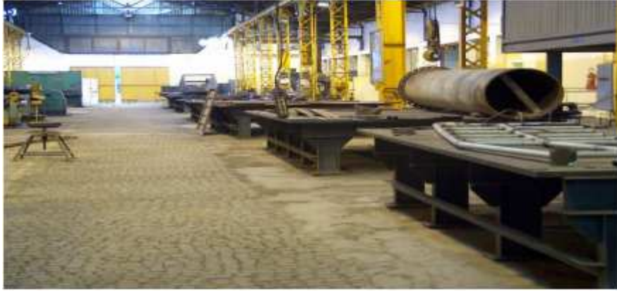
Figure 11 : La section Chaudronnerie.
