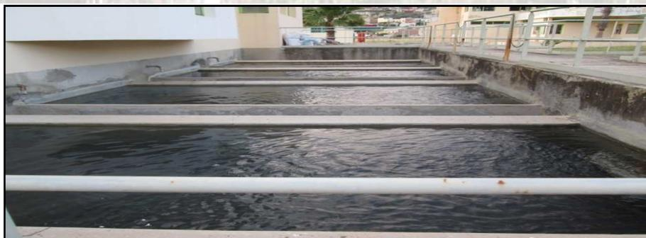
**Figure 3: Photo des filtres à sable**
