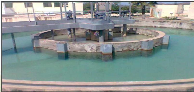
**Figure 2: Photo du décanteur**
