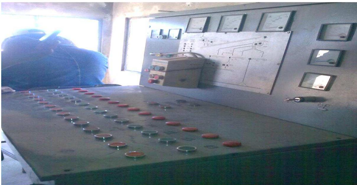
*FIG3 .Boite de commande de l'usine de concassage*
