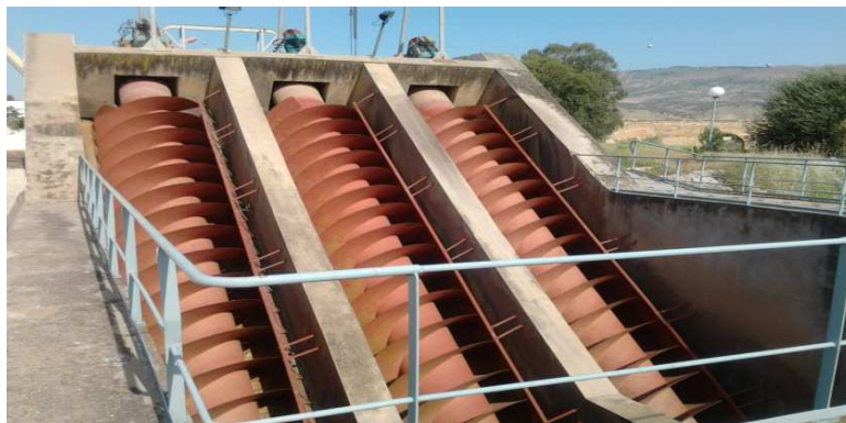
Photo 2 : Opération de relevage dans la station de prétraitement.
