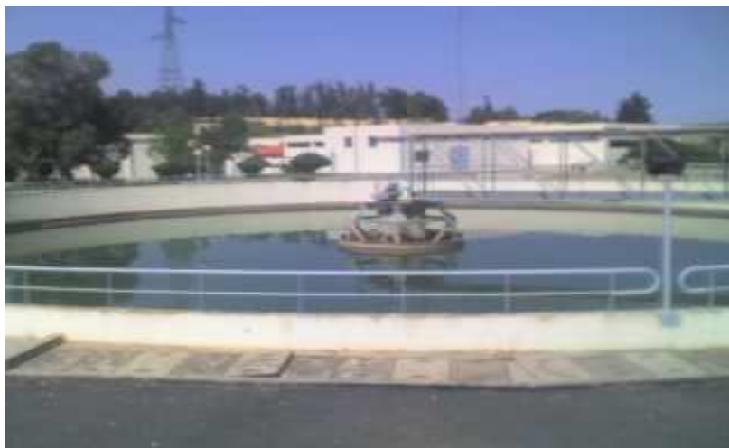
Photo4 : Opération de débouillage dans la station de prétraitement.
