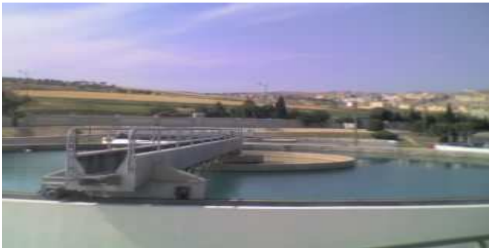
Photo5 : Opération de décantation dans la station de traitement.
