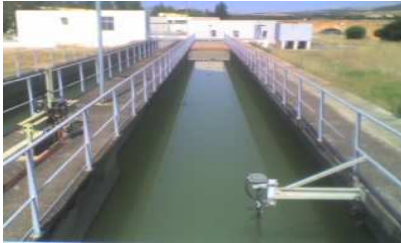
Photo3 : Opération de dessablage dans la station de prétraitement.
