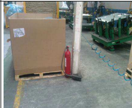
Extincteur non fonctionnel par terre
