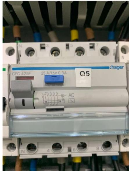
*Figure 12 : Interrupteur différentiel*
